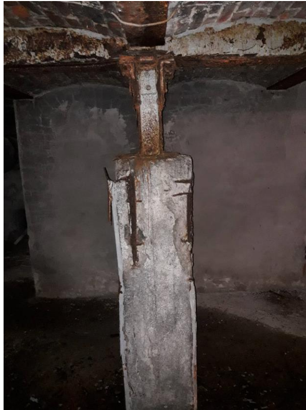
Rys. 14.5 Skorodowany słup pomieszczenia składu opału
