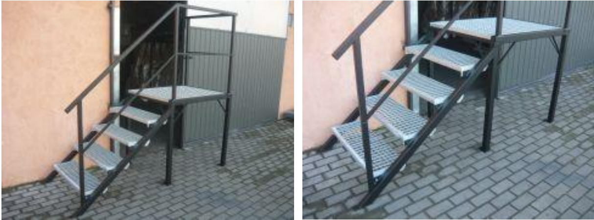
Fot. 18.6.5 – 18.6.6 Przykład schodów prefabrykowanych prostych z podestem
