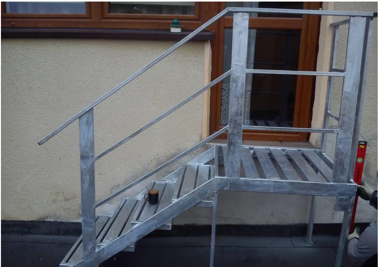
Fot. 18.6.7 Przykład schodów zewnętrznych prefabrykowanych
