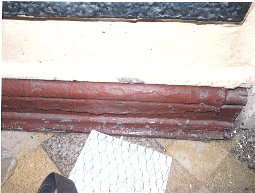
Fot. 9. Korytarz na II piętrze. Nieestetyczna naprawa i wiele warstw przemalowań na listwie przypodłogowej.
