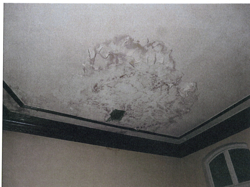
Fot. 2. Drewniana klatka schodowa. Sufit z odparzonym tynkiem na skutek działania wody.
