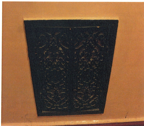
Kratka w ścianie zastępująca zamurowany otwór.
