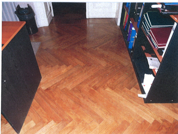
Podłoga- parkiet klepkowy, zachowana listwa przypodłogowa
