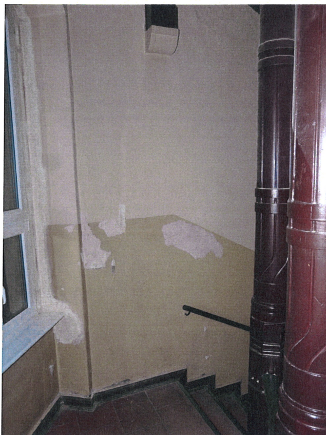
Fot. 4. Drewniana klatka schodowa. Ściana z łuszczącą się, specherzoną farbą.
