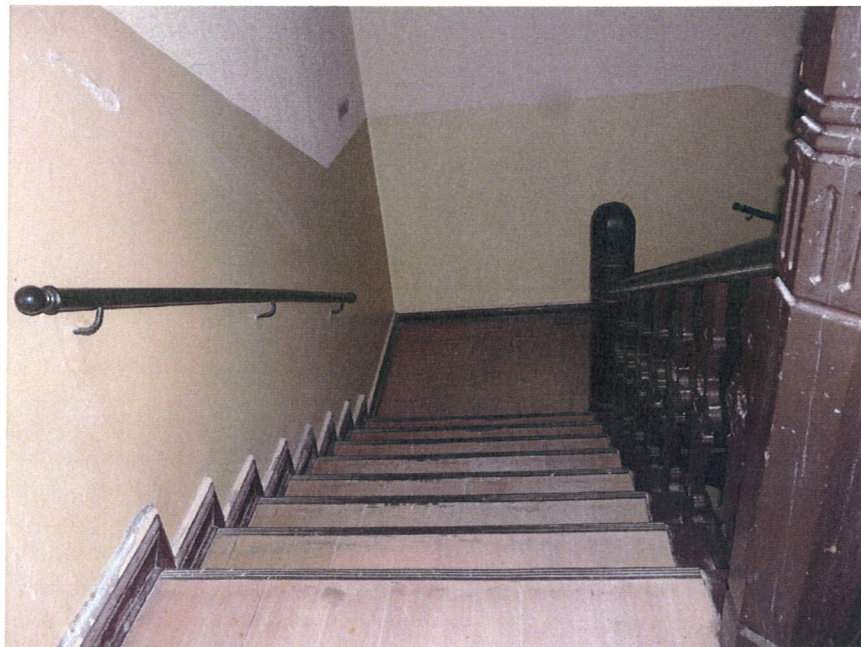
Fot. 5. Drewniana klatka schodowa. Schody pokryte linoleum. Ubytki w tynku na ścianie.
