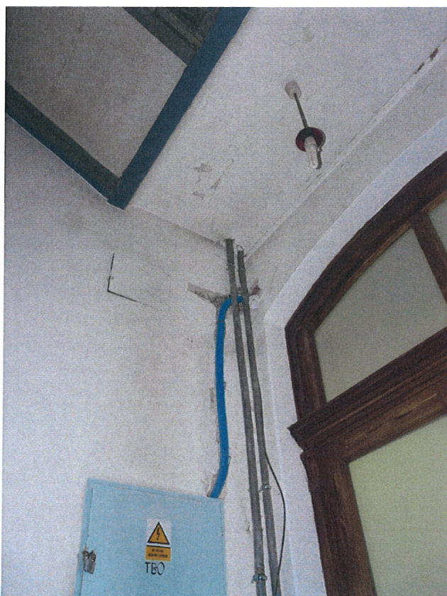
Fot. 24. Betonowa klatka schodowa. Instalacje poprowadzone na zewnątrz.
