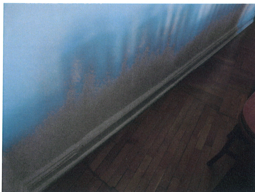
Fot. 28. Podłoga- parkiet uzupełniana wtórnie klepkami mniejszego rozmiaru, innym układzie. Listwa przypodłogowa uzupełniona bez zachowania profilu.
