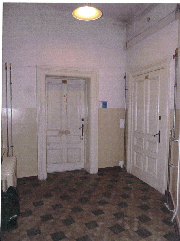
Fot. 8. Korytarz na II piętrze. Instalacje poprowadzone na zewnątrz ścian. Stolarki drzwiowe z ubytkami w warstwie malarskiej.
