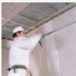
Na każdej ścianie wyznaczamy poziom zamocowania sufitu. Rysujemy poziome linie przy użyciu poziomnicy. Wzdłuż linii montujemy profile UD.
