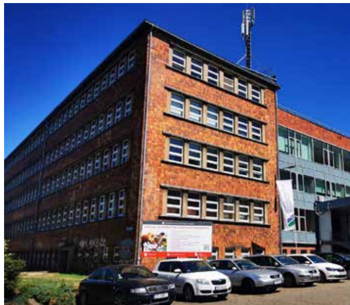
Budynek Wydziału Budownictwa i Inżynierii Środowiska
