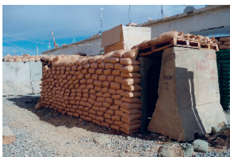
Fot. 79. Wykorzystanie worków do ochrony schronów żelbetowych.
