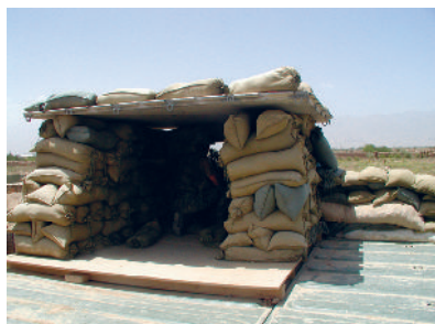
Fot. 76. Wykorzystanie worków do ochrony posterunku.
