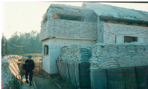
Fot. 77. Wykorzystanie worków do ochrony budynku.
