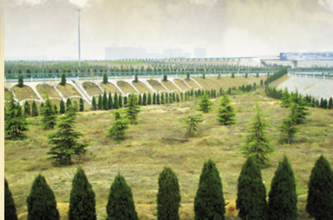
Wzmocnienie skarp i zagospodarowanie terenu w okolicy węzła autostradowego
