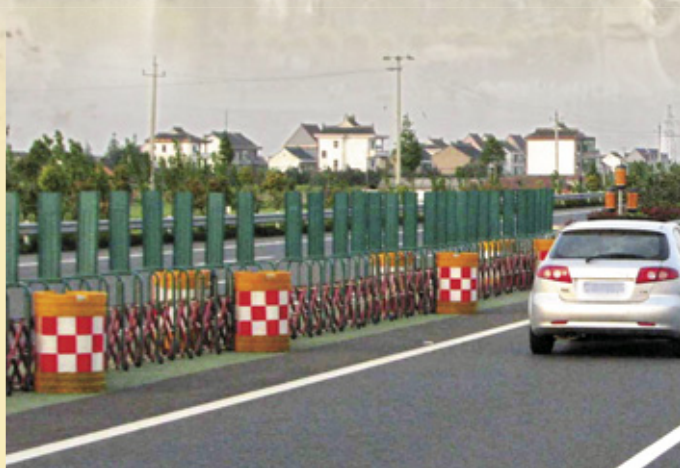
Różne przenośne urządzenia ochronne zastosowane na przejazdach awaryjnych
