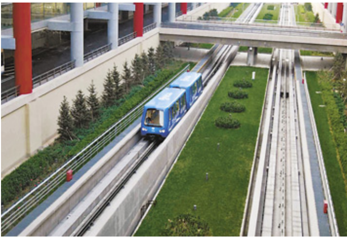
Minipociąg w tunelu T3
